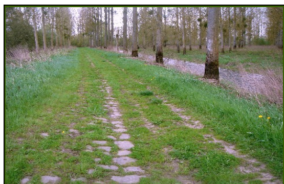
Photo 6- La chaussée et le vivier © J-J Godfroid, 28/04/06
