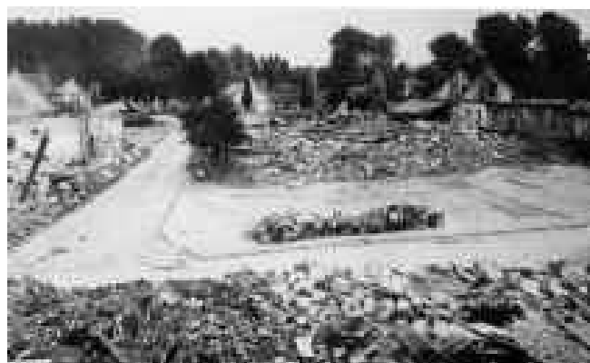
1917- Le centre de Manicamp dévasté Site de l'école publique de Manicamp
