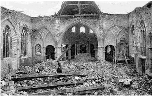
Eglise Saint-Martin effondrée
